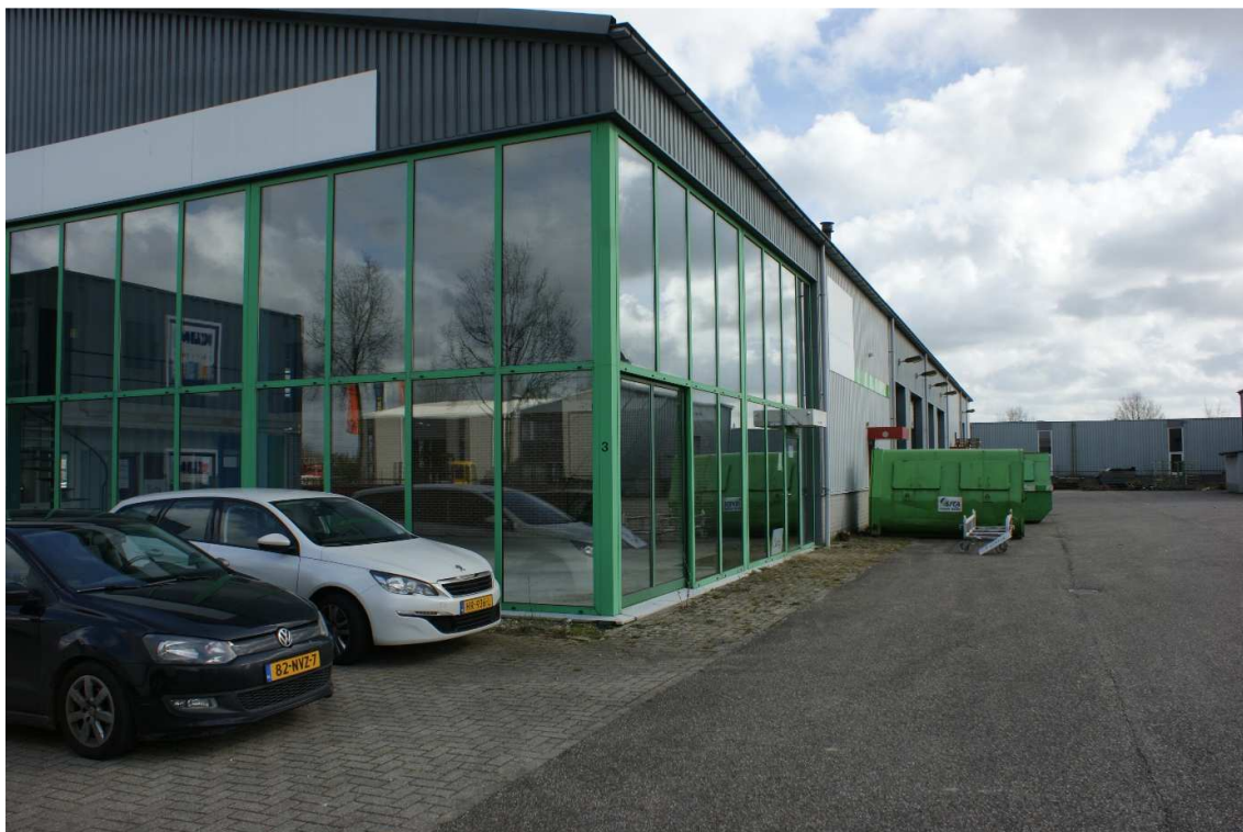
Figuur 2.3. Leegstaande loods
