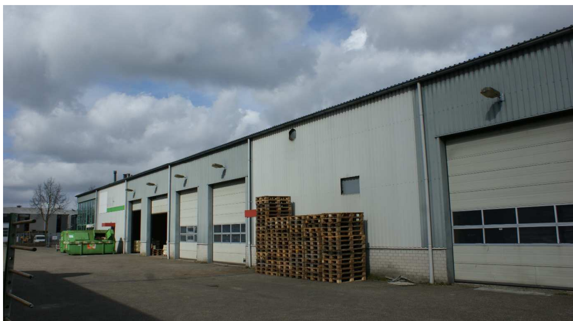
Figuur 2.5. Leegstaande loods
