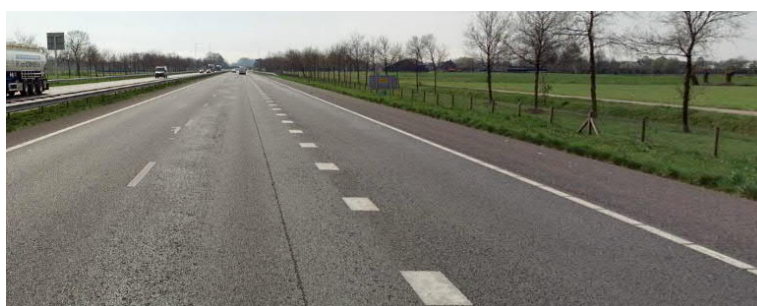
Foto ter hoogte van blokmarkering
